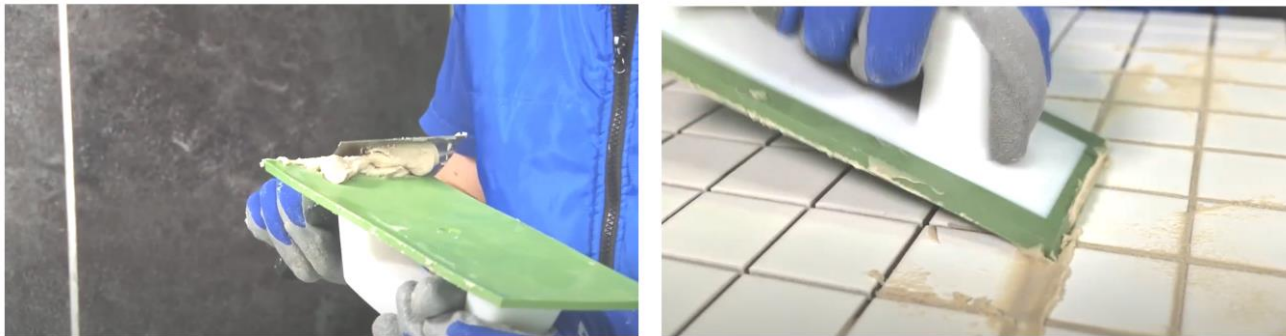
Рис. 43. Заполнение швов затиркой при помощи резинового шпателя
